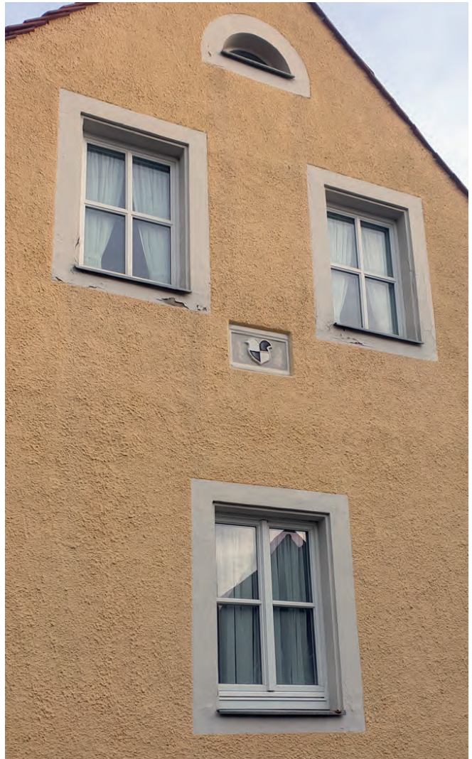
Sprossenfenster mit Putzfasche
