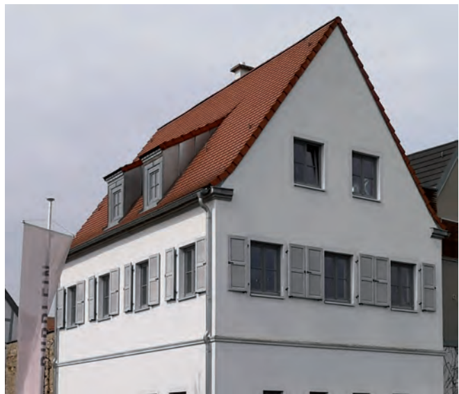
Schleppgauben an saniertem Gebäude
