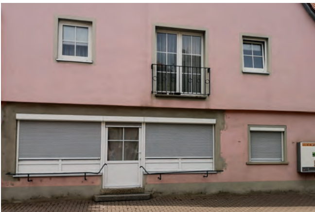
Negativbeispiele: Unharmonische Fassadengestaltung durch nicht aufeinander abgestimmte Fensterformate und -anordnung
