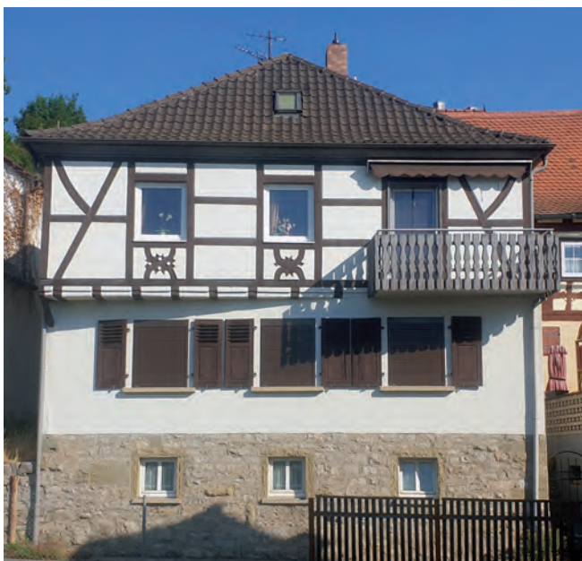
Negativbeispiel: nachträglich angebauter Balkon stört historische Fassade
