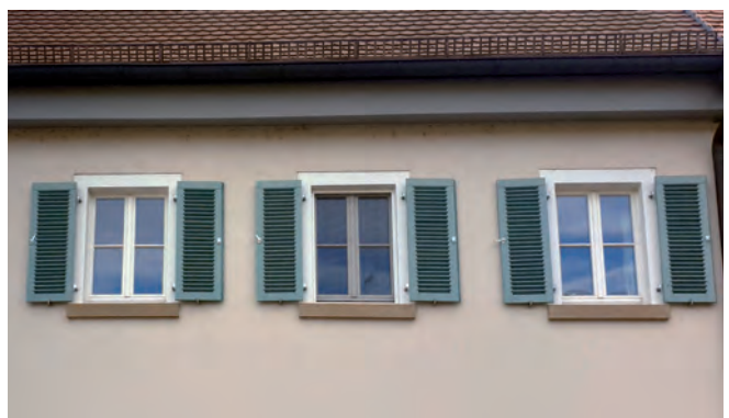
Sprossenfenster mit Holzläden
