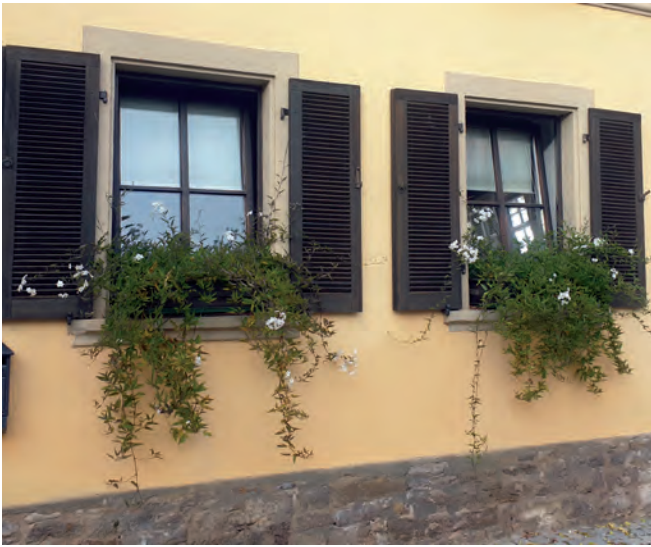
Fenster mit Natursteingewänden und Klappläden
