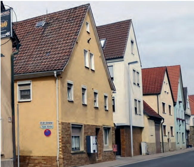
Satteldach als übliche Dachform
