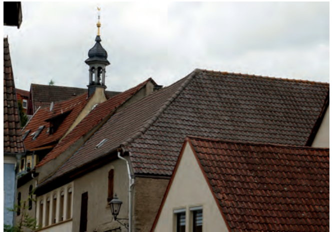
Ruhige, geschlossenen Dachlandschaft in Mainstockheim
