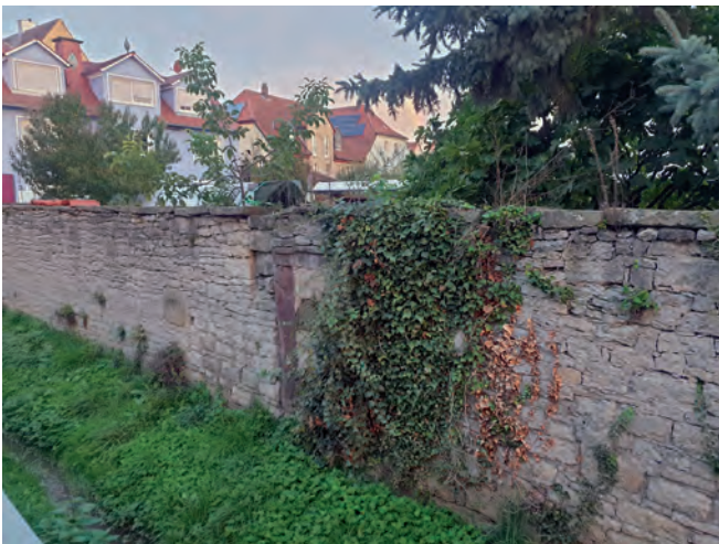
Sonderfall: Mauer als Einfriedung historischer Grünbereiche
