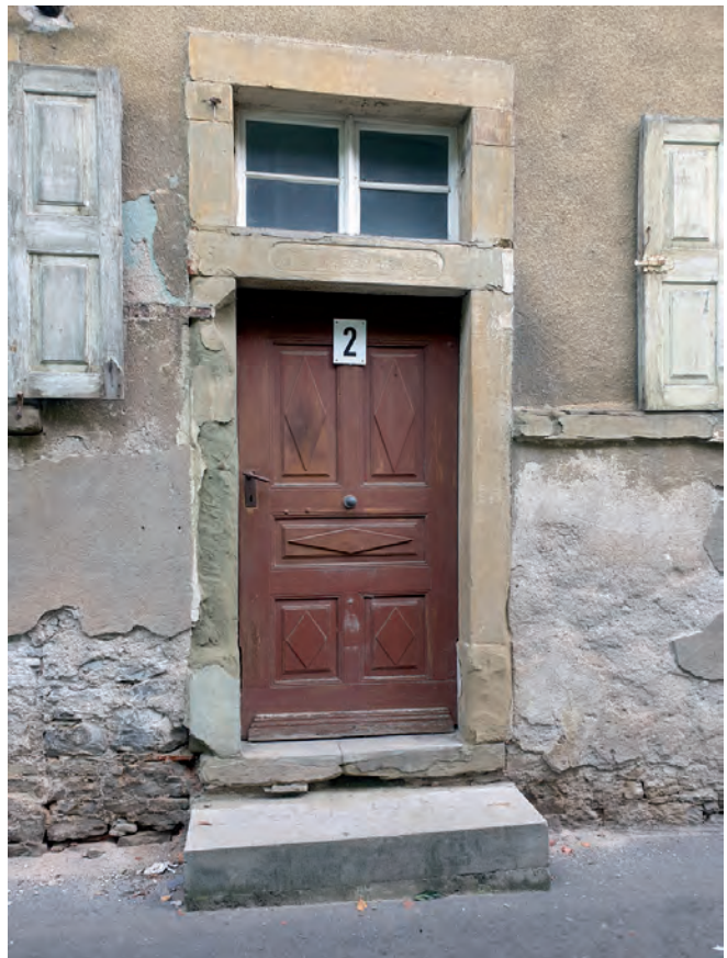
Historische Eingangstüre mit Belichtungsfenster
