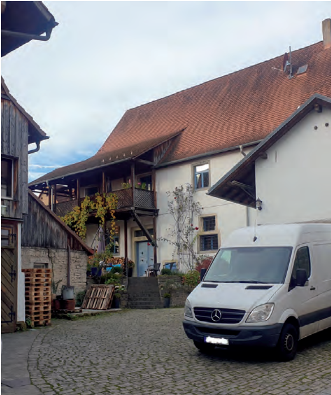
Laubengang als Holzkonstruktion im Hof
