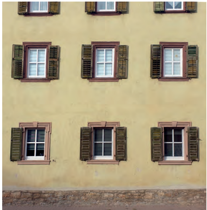
Lochfassade mit gleichmäßiger Fensteranordnung
