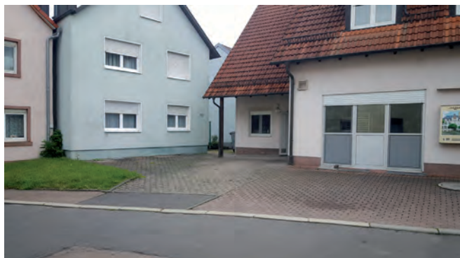
Negativbeispiel: Großflächige Versiegelung des Hofes
