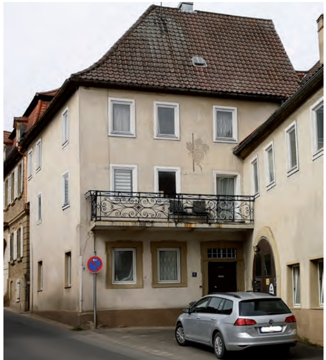
Balkon als leichte Metallkonstruktion
