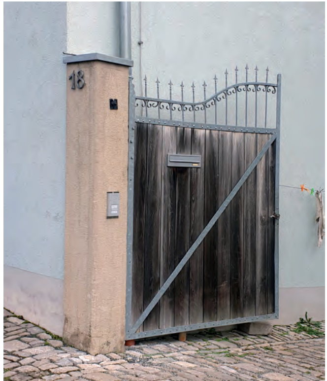
Metalltor mit Holzverkleidung als Hofabschluss
