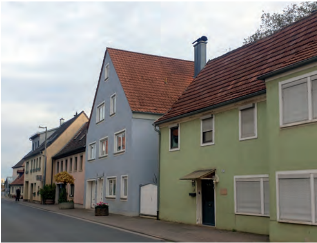
Typische Putzfassaden in der Ortsmitte
