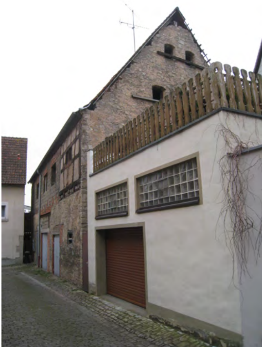
Sanierungsschwerpunkt Eselshof I
