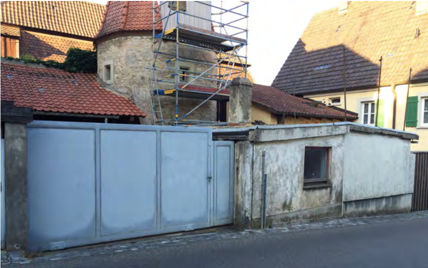
Verstellte Ansicht der Befestigungsmauer mit störenden Anbauten und unpassenden Toren
