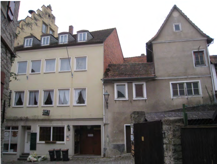
Sanierungsschwerpunkt Bereich hinterm Rathaus / Langengasse
