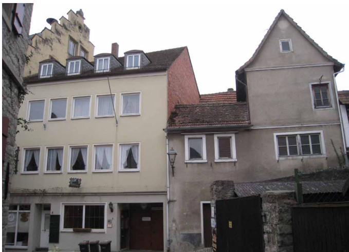
Bestandsgebäude Langengasse 1 (links)
