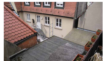
Blick vom Balkon Bestandsgebäude in den Hof
